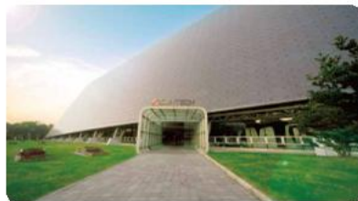
1MW | 尚德总部生态大楼光伏建筑一体化项目 无锡·中国 | BIPV项目
