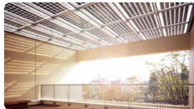
10KW | 日本-光华初级小学光伏建筑一体化项目 东京·日本 | BIPV项目
