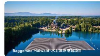
750KW | 德国最大的水上漂浮式光伏电站 巴登符腾堡州·德国 | 水上漂浮
