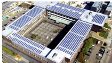
239.4KW | 比利时-Genk市政厅屋顶太阳能电站项目 亨克·比利时 | 工商业屋顶
