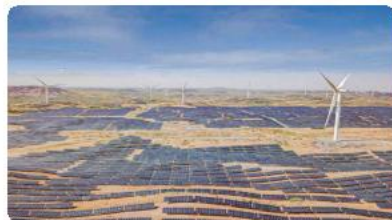
400MW | 宁夏卫钢国开新能源集采项目 宁夏·中国 | 地面电站
