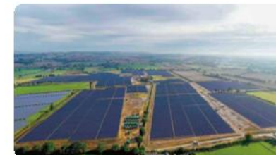
34.7MW | 英国首个双面双玻光伏电站 约克郡·英国 | 地面电站
