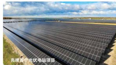
27MW | 壳牌-Moerdijk太阳能公园电站项目 鹿特丹·荷兰 | 地面电站
