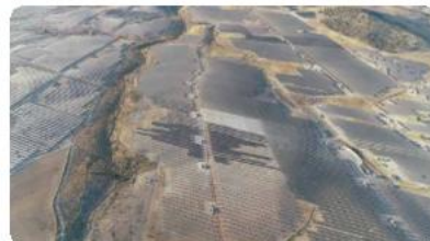
500MW (尚德供货100MW) | 欧洲最大的光伏电站 埃斯特雷马杜拉·西班牙 | 地面电站
