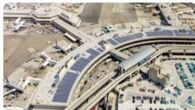
450KW | 旧金山-国际机场T3航站楼屋顶太阳能电站项目 加利福尼亚·美国 | 工商业屋顶
