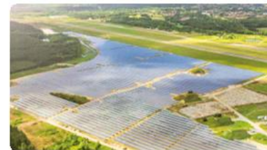
24.24MW | 德国-Finow太阳能电站项目 埃伯斯瓦尔德·德国 | 地面电站
